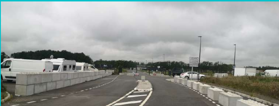
Blocs de béton anti-intrusion devant les caravanes à Montbert (44) Crédit : Nara Ritz
